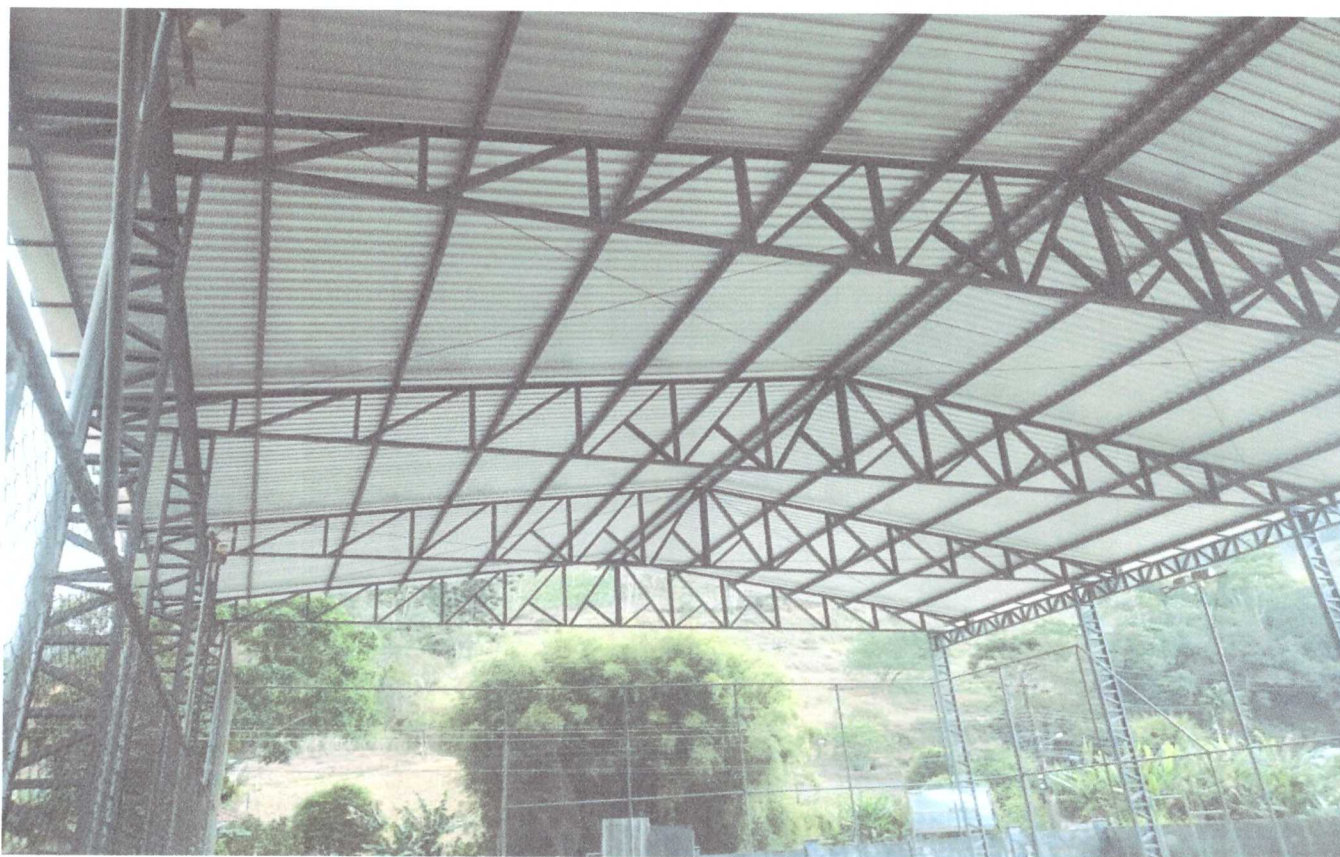
COLOCAÇÃO DE COBERTURA NA QUADRA
