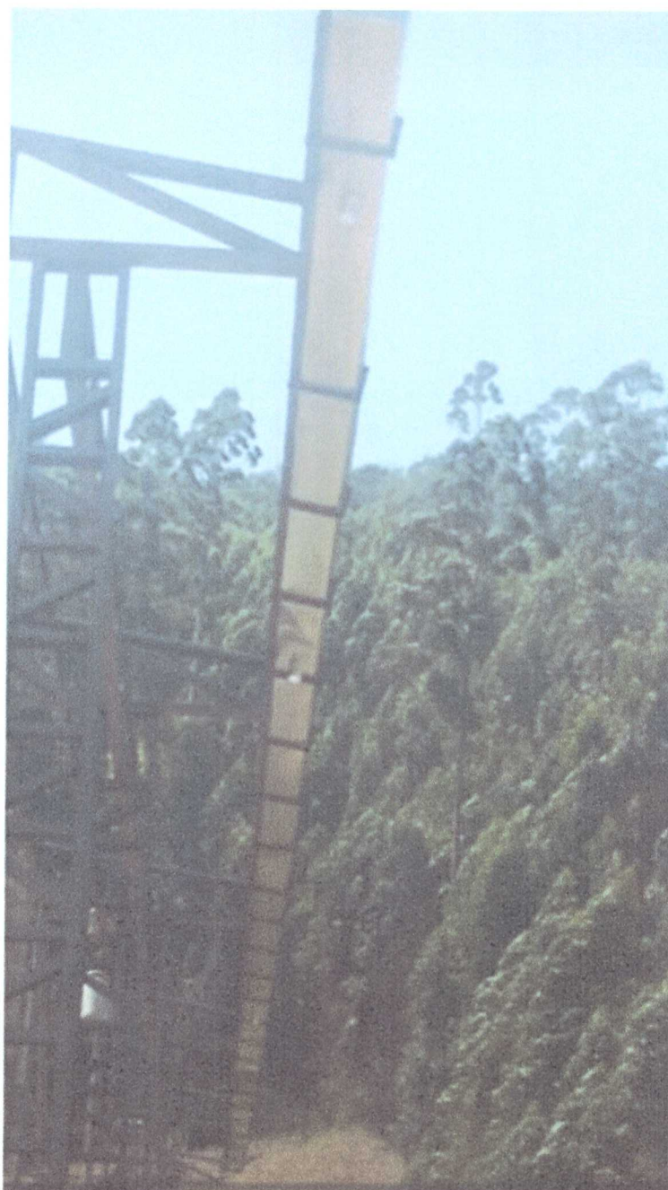
COLOCAÇÃO DE CALHA METALICA
