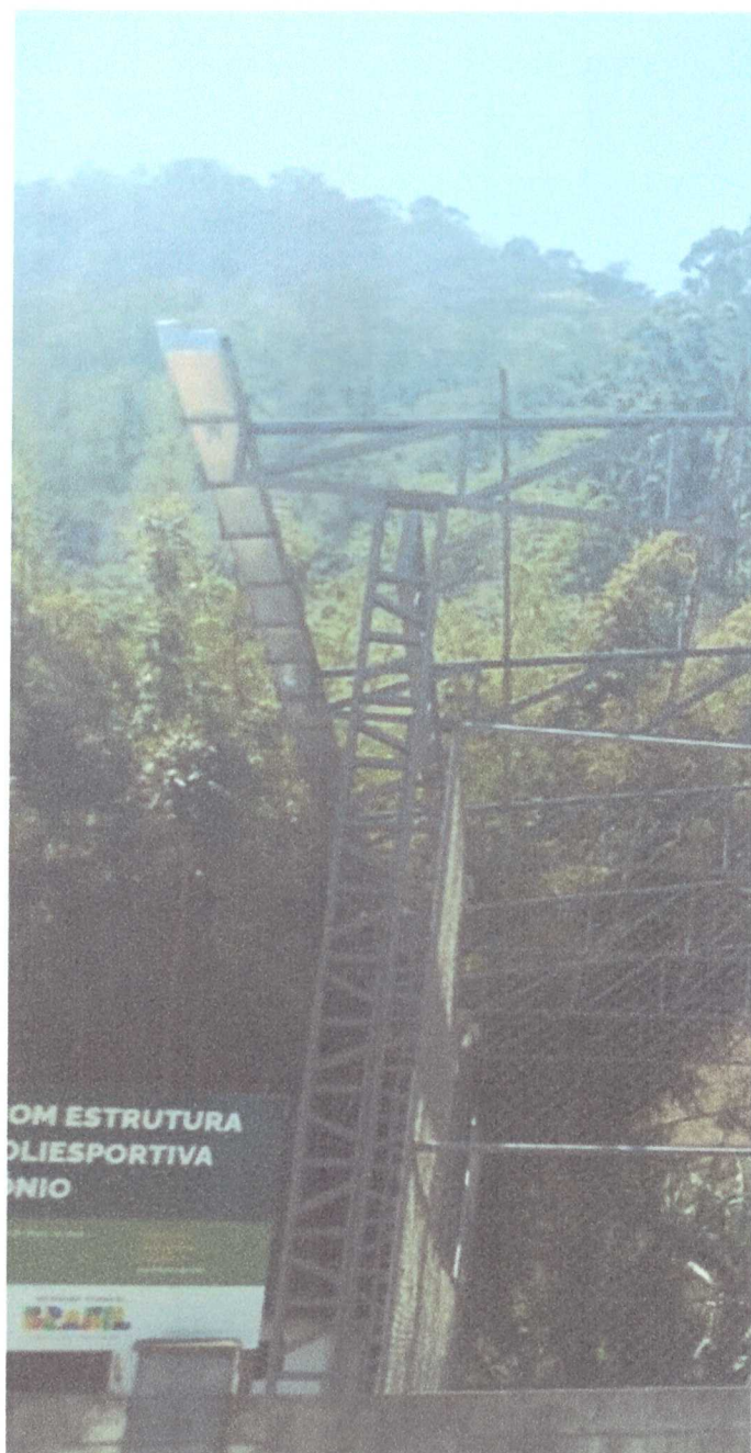
COLOCAÇÃO DE CALHA METALICA
