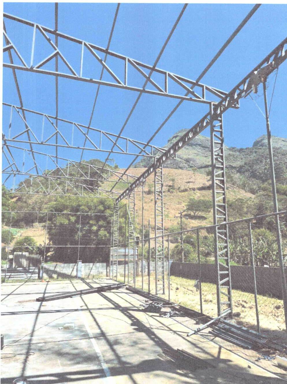
CONFEÇÃO E COLOCAÇÃO DE ESTRUTURA METALICA DA COBERTURA
