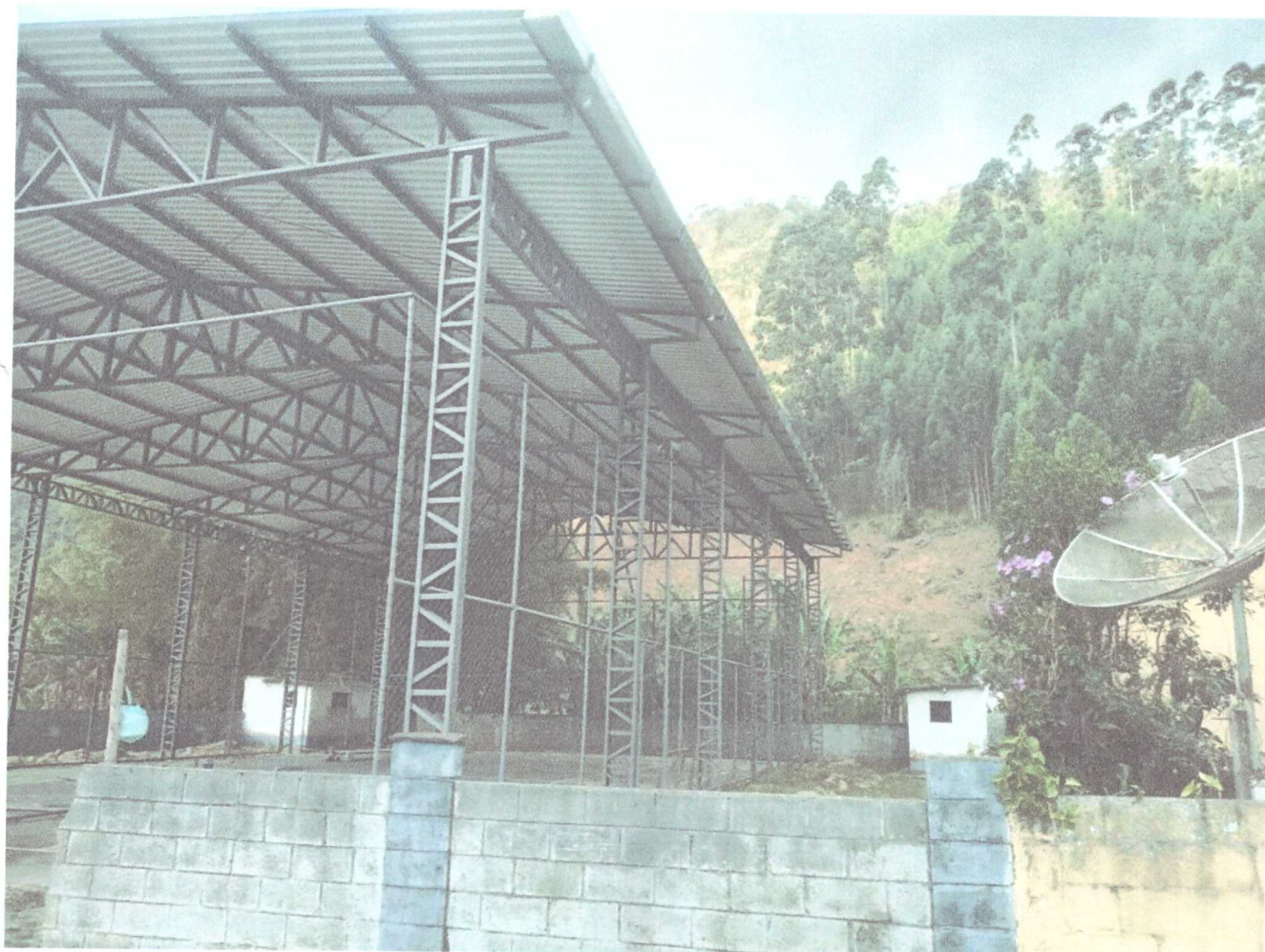
COLOCAÇÃO DE COBERTURA NA QUADRA
