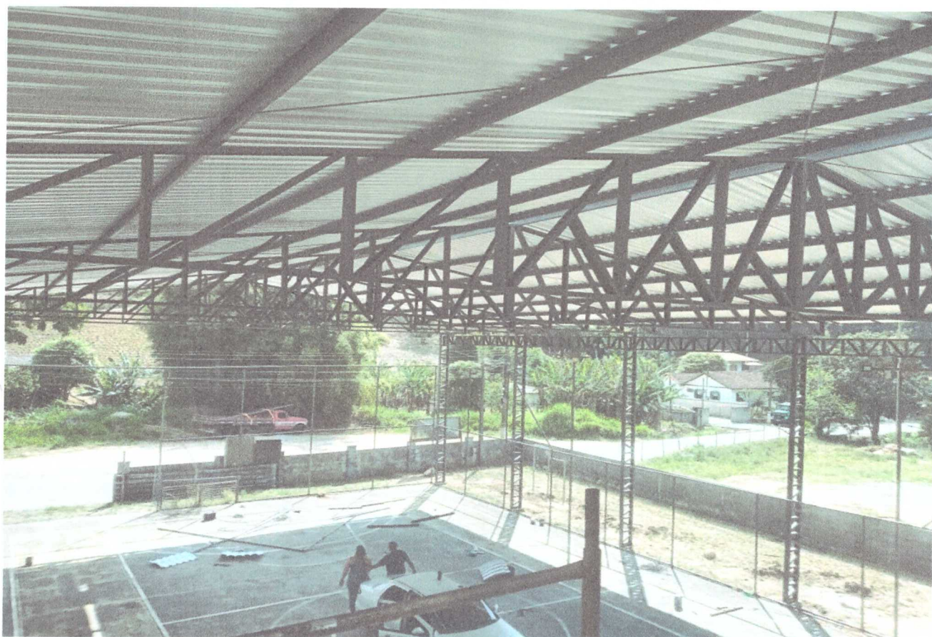
COLOCAÇÃO DE COBERTURA NA QUADRA
